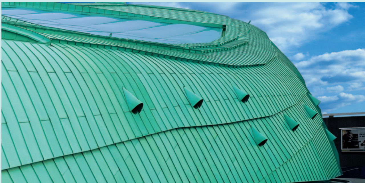
Rivestimento in Tecu® Patina dell'International Centre for Life di Newcastle-Gran Bretagna
