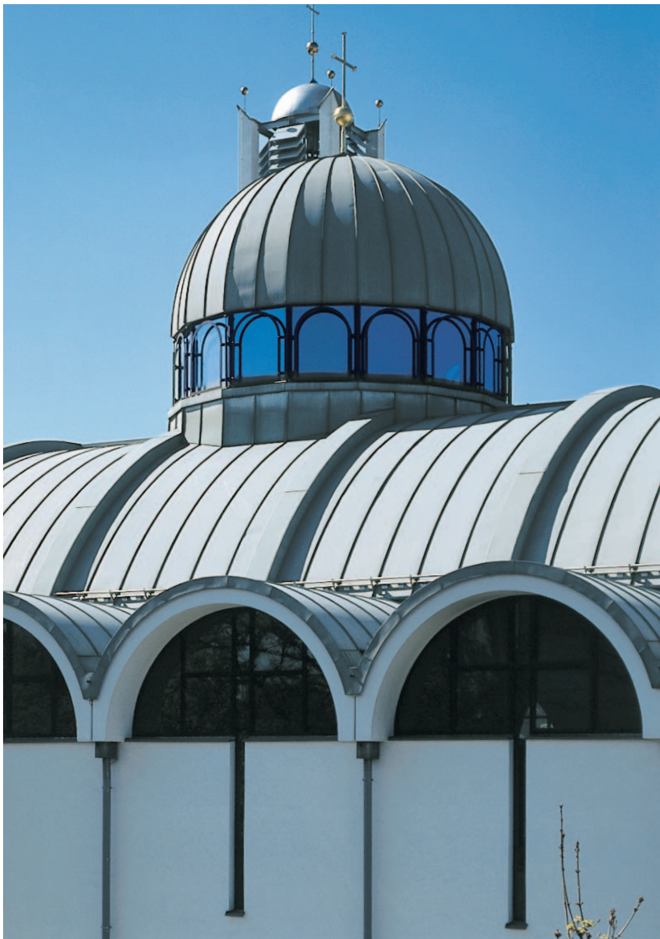
Copertura in Tecu® Zinn della chiesa greco-ortodossa a Monaco di Baviera-Germania
